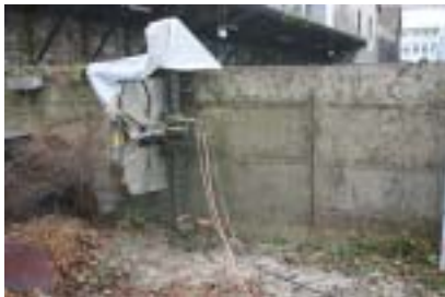
Betonfräse angesetzt.
